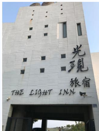
墾丁光現旅宿 降諧波節電組件安裝位置
