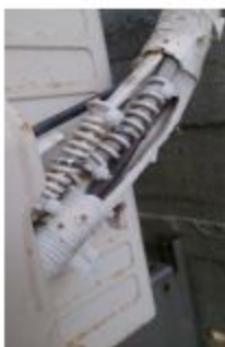
冷氣室外機 15 台 每台 2 支 共 30 支
