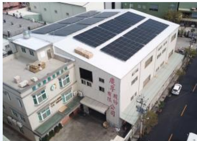
太陽光電發電系統 台南順安工業區電場
